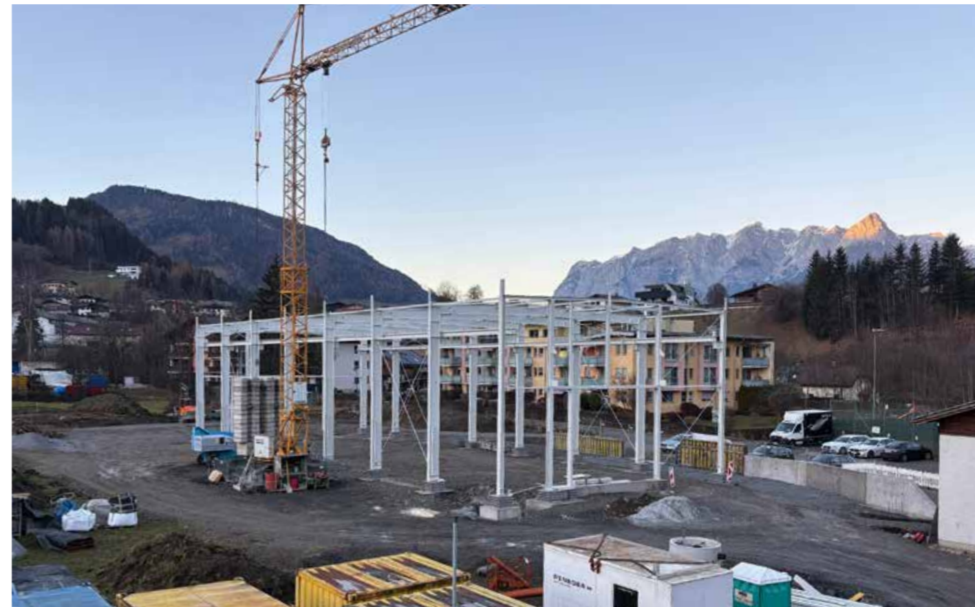
Oben: Ende 2025 haben die Bauarbeiten begonnen. Schon im Vorfeld wurde viel Wert auf den informativen Austausch mit den Anwohnern gelegt. Unten: Während der Fertigstellung der Außenwände wurde parallel der Innenausbau der Halle vorbereitet.
